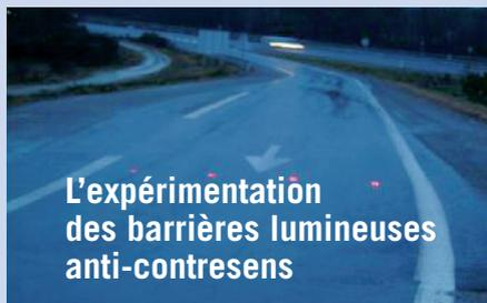
Lancée en 2006 par les DDE de Loire-Atlantique, du Morbihan et du Finistère, en lien avec la DSCR, cette expérimentation vise à évaluer l'efficacité de dispositifs lumineux visibles par l'utilisateur en contresens (plots au sol avec leds équipées de
